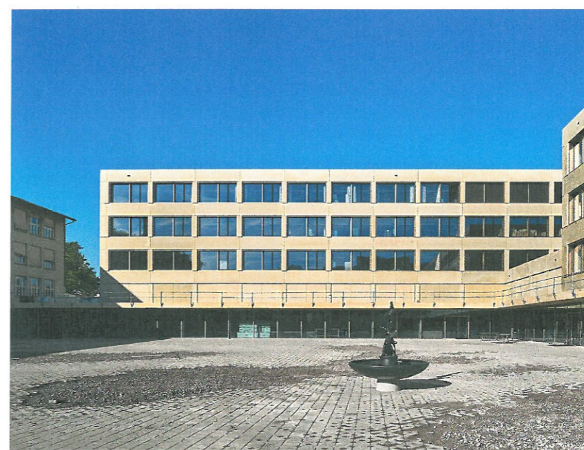
Schulhaus Sandgruben, Altbau (links) und Neubau vom Pausenplatz aus. Der Altbau wird bis Sommer 2017 von Stücheli Architekten instandgesetzt.
